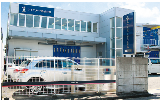
本館・第7工場
